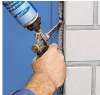
> ... mit Brandschutzschaum ausfüllen ...
