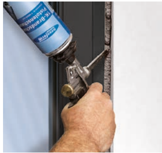
> ... mit Brandschutzschaum ausfüllen ...
